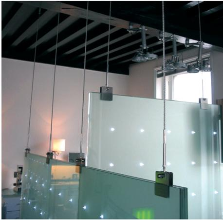
*Die Glas-Metall-Befestigung BackPlate macht es möglich, frei schwebende Trennwände aus Glas sicher zu installieren.*
