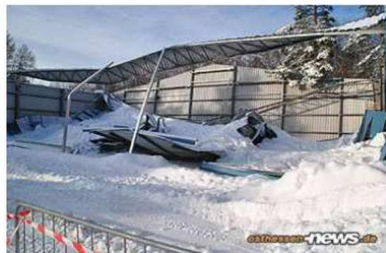
Das Dach der Fahrzeughalle auf Point Alpha ist komplett eingestürzt.
